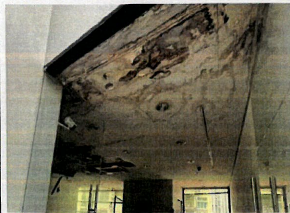
新教學樓三樓電梯對出原木天花板
