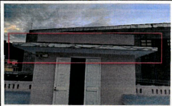
舊教學樓天台外牆
