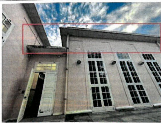
舊教學樓天台外牆
