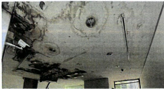
新教學樓三樓電梯對出原木天花板
