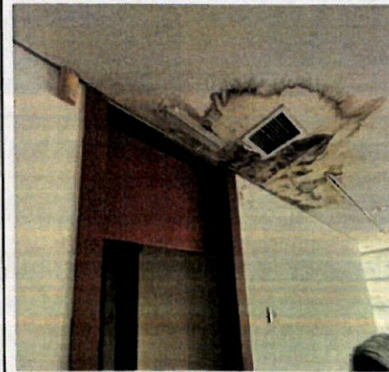
新教學樓三樓電梯對出原木天花板
